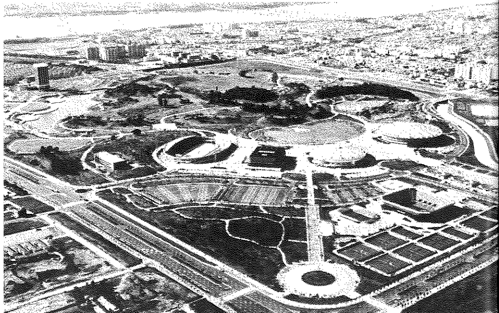
Olympic Park Parc Olympique
